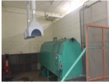
Vista exterior de tanque
