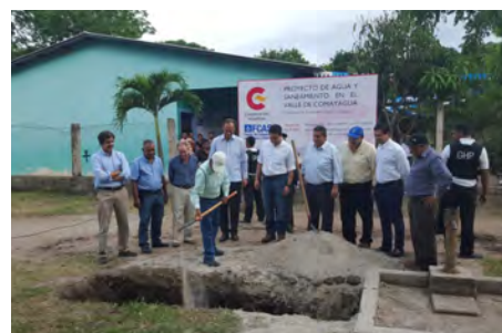
Lanzamiento del proyecto "Agua y Saneamiento en el Valle de Comayagua"
