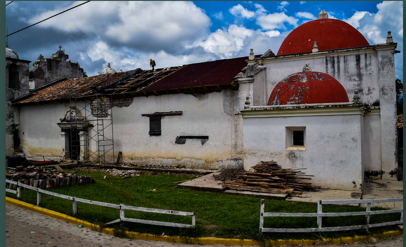
A. Ferrando. Cubierta de la iglesia de San Sebastián Mártir durante la restauración de su cubierta
