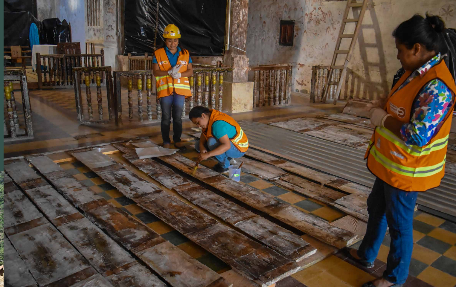
A. Ferrando. Voluntarias locales realizando la protección del entablado de madera policromada interior de la iglesia de San Manuel Colohete
