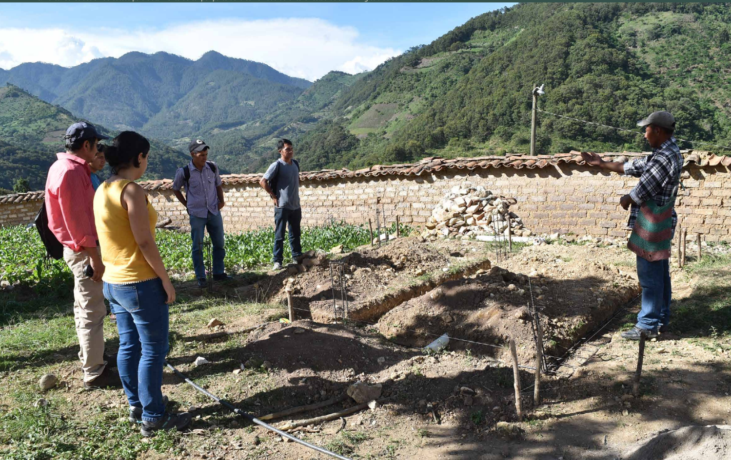
C. Dares. Construcción de bateas para tratamiento de cal por parte de la comunidad durante la restauración de la iglesia de San Manuel Colohete
