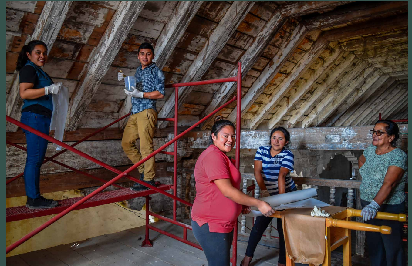
AECID. A. Ferrando. Voluntarios locales realizando la protección del entablado de madera policromada interior de la iglesia de San Manuel Colohete
