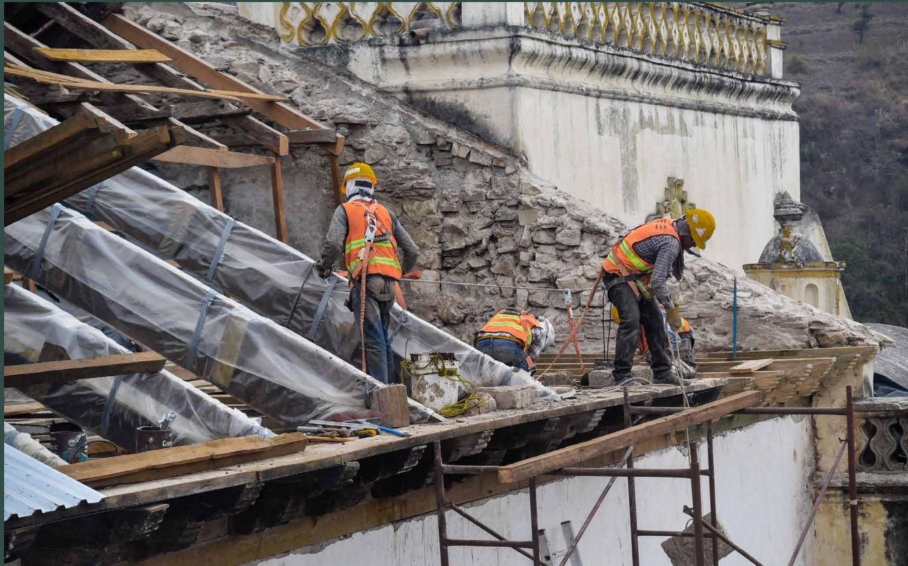
A. Ferrando. Trabajos de restauración de la cubierta de teja en la iglesia de San Manuel Colohete
